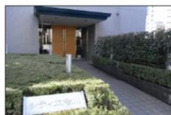
AED（自動体外式除細動器）一体型 BPSを 2021年6月、京急シティ立会川様に設置
